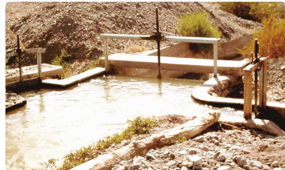
FOTO 05 Compuertas frontal y lateral.
