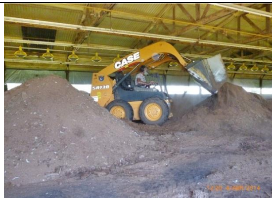
Foto 4- Maquina para formar las pila
