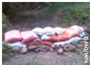
**Diques de contención:** Son muros de piedras, postes, estacones prendedizos o de cualquier otro material, capaz de disminuir la velocidad del agua y retener la tierra que es arrastrada por la lluvia en las zanjas, cauces o canales que se forman dentro de las parcelas. Se construyen perpendicularmente y con forma de media luna para darle mayor resistencia.
