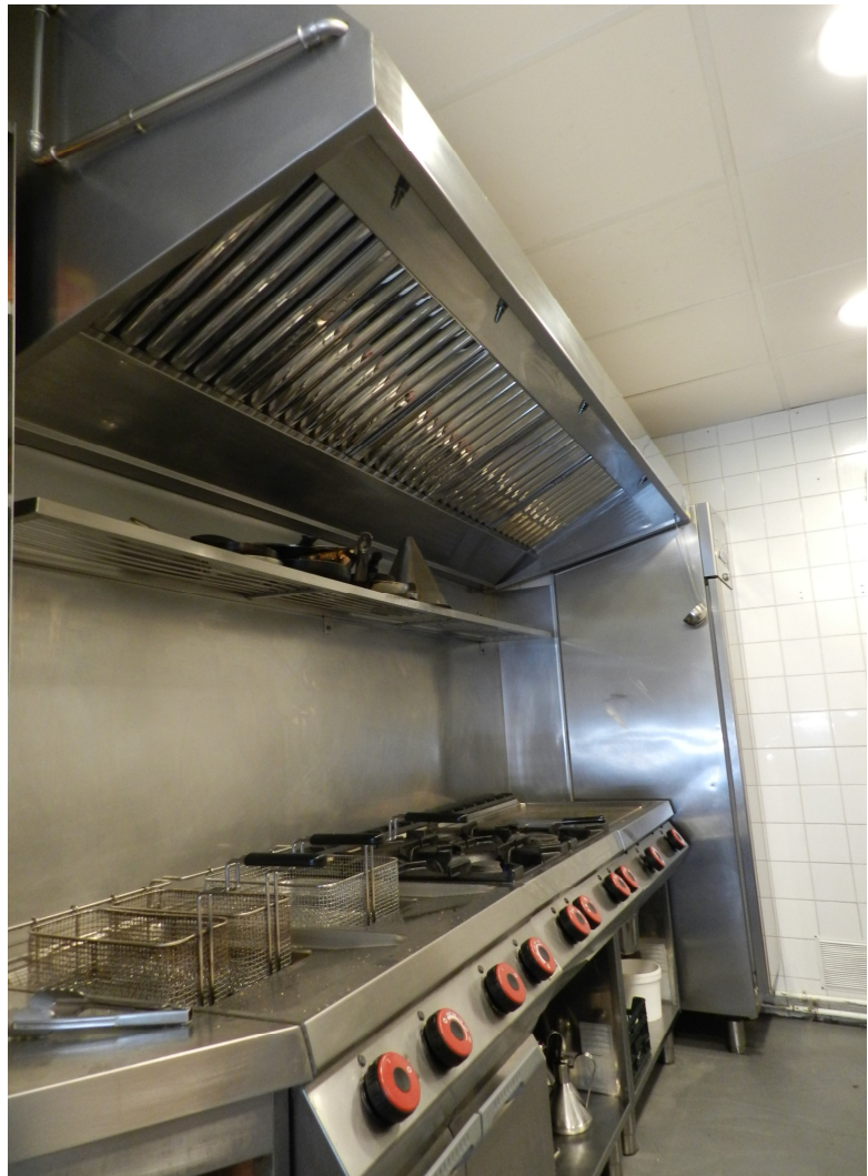
Imagen nº 1. Campana extractora, filtros y línea de fuegos donde se elaboran alimentos. Fuente: Rte. Santa Catalina (Valencia)
