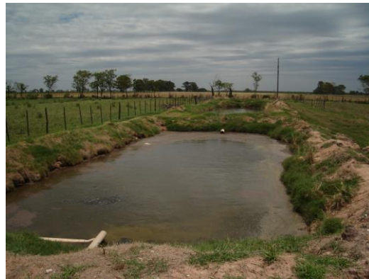
Foto 3: Laguna anaeróbica. Fuente: Estación Experimental INTA Rafaela
