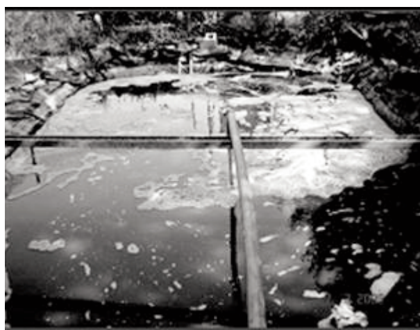
Figura 1. Tratamiento del agua residual en un reactor biológico. UNRC, Río Cuarto, Córdoba.
